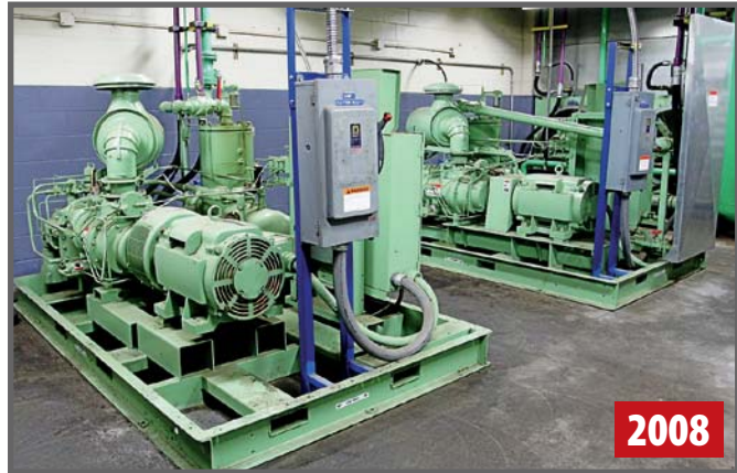
(2) SULLAIR 125 HP AIR COMPRESSORS
