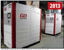
GARDNER DENVER VS25-40A02 34 HP VARIABLE SPEED AIR COMPRESSORS
